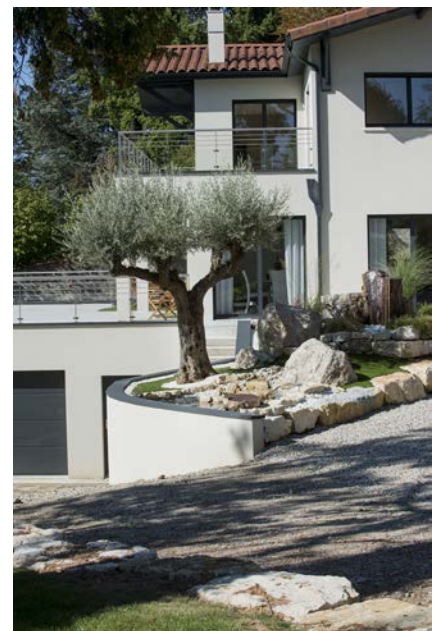
Maison en cours de construction
